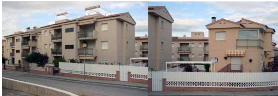
1988 · c/ Pàndols – Av. Oliveres · Torredembarra · Tarragona
